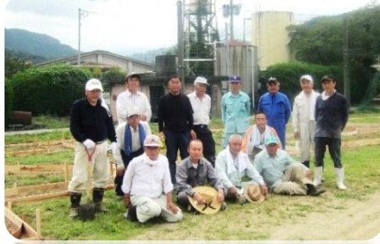
生コン打ち↓ コンボ君活躍中 コンクリート柵の 設置完了!←
