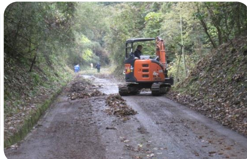
↑ 作業中のようす
