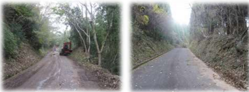
ユンボを動員しての作業風景 と 綺麗な仕上がりに
