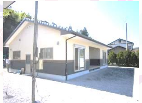
※写真は完成済みの下恵良住宅 ※募集の六郎丸住宅は平成30年3月完成予定
